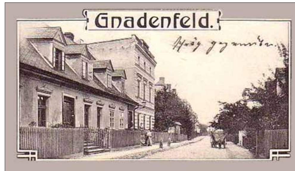
Budynek apteki w Gnadenfeld (dwupiętrowy), dziś apteka „Pod miłorzębem”, fragment pocztówki pocz. XX w.
