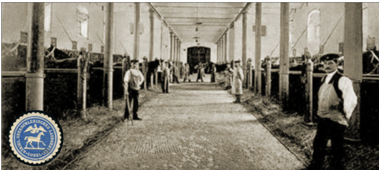
W Królewskiej Stadninie Ogierów w Koźlu hodowano: konie śląskie, lekkie ogiery pruskie (trakeny – wyjazdowe i pod wierzch), hanowerskie, oldenburskie i rasy zimnokrwiste, np. reńsko-belgijskie
