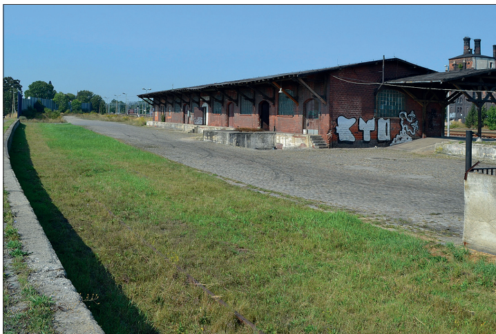
5. Budynek ekspedycji towarowej w Chojnowie (niem. Haynau ) z wybrukowanym placem-drogą dojazdowo-rozładunkową. Obok budynku zarośnięta trawą bocznicą kolejową (na poziomie gruntu), a na podwyższonej rampie bocznej – drugi tor załadunkowy. (fot. S. Kaiser)
