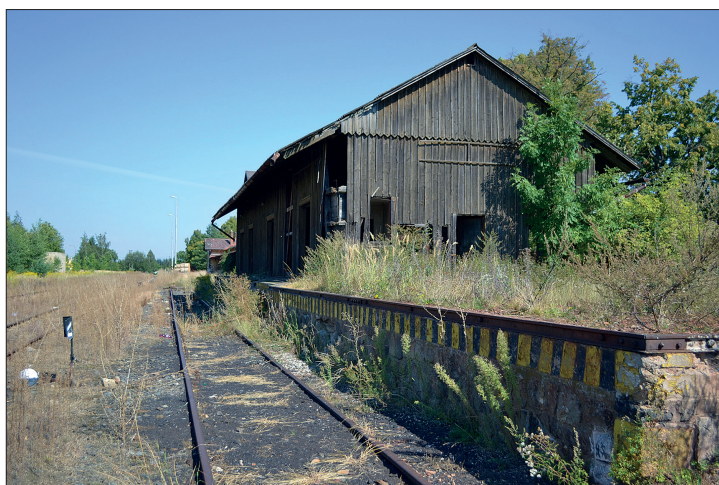
11. Wczesna forma kolejowej wieży ciśnień (najwyższa, środkowa część budynku po lewej stronie) z pomieszczeniami mieszkalnymi dla kolejarzy w Ozimku (niem. Malapane ). (fot. S. Kaiser)
