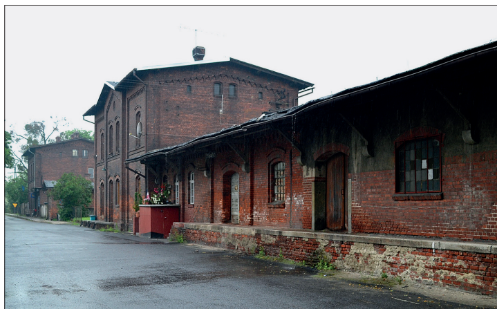
3. Dworzec kolejowy w Łambinowicach (niem. Lamsdorf ) z bezpośrednio przylegającym do niego budynkiem ekspedycji kolejowej. Widok od strony drogi dojazdowej. (fot. S. Kaiser)
