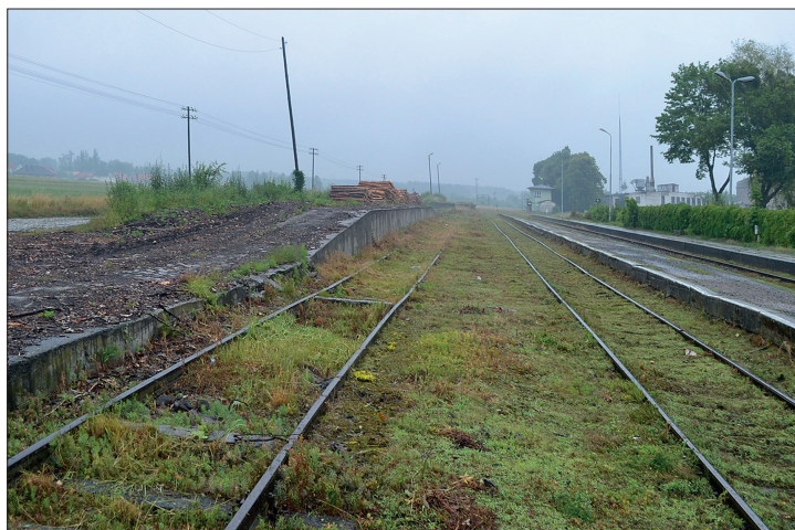
4. Dworzec kolejowy w Łambinowicach (niem. Lamsdorf ). Po prawej stronie tory dla pociągów osobowych z peronami oraz jeden tor przeznaczony dla składów towarowych (po lewej stronie). Tor towarowy po przeciwnej stronie budynku stacji osobowej posiada obniżoną i podwyższoną przestrzeń rozładunkową. Dzięki temu zabiegowi w jej przedniej części wagony z produktami rolnymi mogły zostać załadowane lub rozładowane. Na zdjęciu widoczne również pnie drzew przygotowane do załadunku. Niezwykła długość peronów na stacji Łambinowice wynika bezpośrednio z dużego niegdyś natężenia wojskowych transportów kolejowych do znajdującego się tu w czasach pruskich poligonu. Dzięki odpowiedniej rampie bocznej konie mogły być w szybkim tempie w(y)prowadzane do zadaszonych wagonów lub specjalnych wagonów-platform. Ten często ćwiczony manewr był niezwykle ważny dla zachowania zdolności wojska do szybkiej mobilizacji oraz przemieszczania się. (fot. S. Kaiser)
