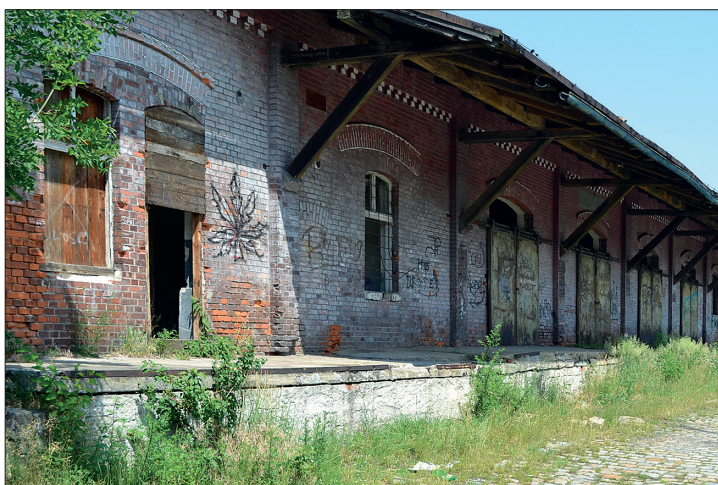
6. Budynek ekspedycji kolejowej w Prudniku (niem. Neustadt O.S. ) z wyłożoną granitową kostką drogą rozładunkową. (fot. S. Kaiser)
