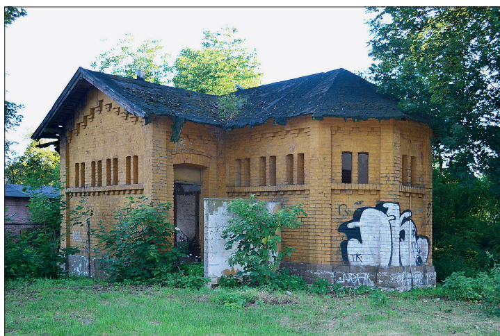
18. Budynek toalet dworcowych w Koźlu (niem. Cosel ) (fot. S. Kaiser)
