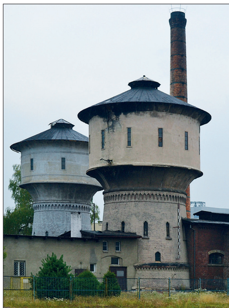
15a–d. Różne kształty i stany zachowania wież wodnych w Strzegomiu (niem. Striegau ), Piławie Dolnej (niem. Gnadenfrei ), Namysławie (niem. Namslau ) i Jeleniej Górze (niem. Hirschberg i. Schl. ) – tu widoczne dwie wieże typu Intze. (fot. S. Kaiser)
